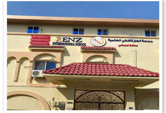
مبنى تعليمي بحي الرحاب.
